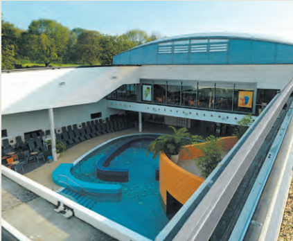
大型屋根の開閉装置
